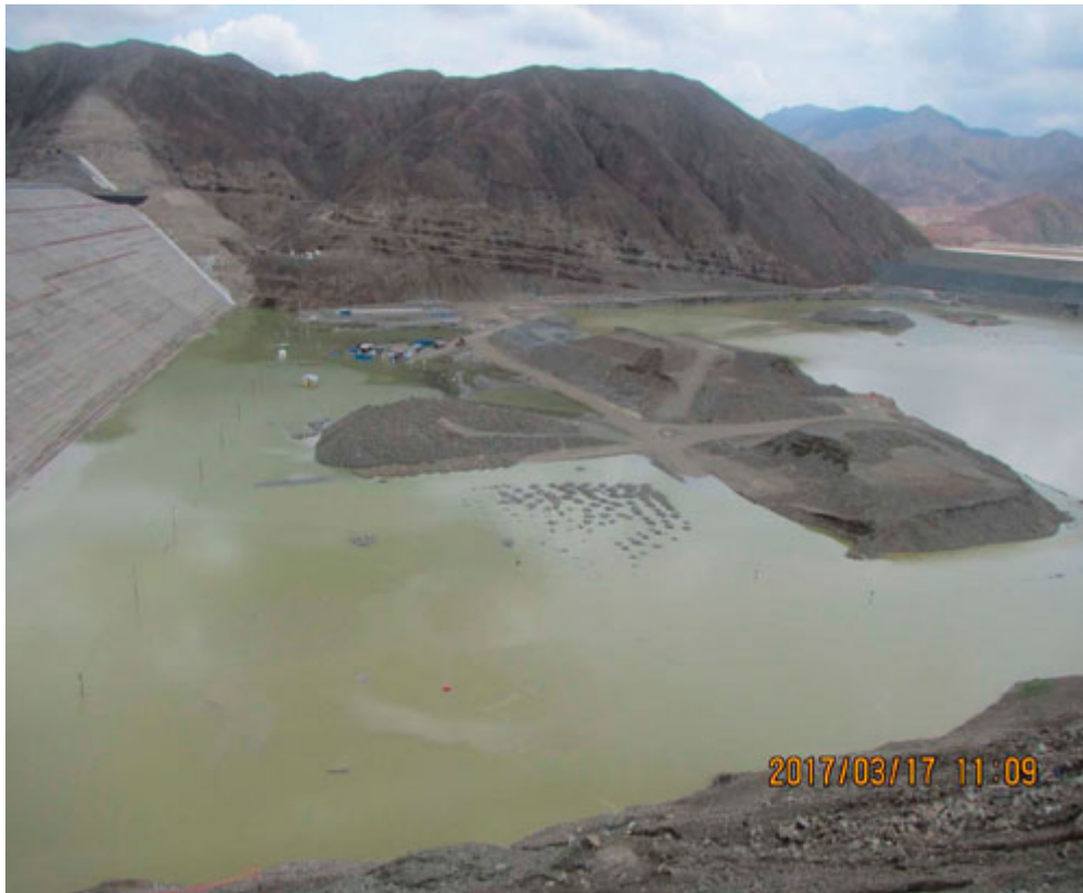
Figura 3: El Niño Costero 2017 en Palo Redondo: Embalse de agua de 11 m de altura (4 millones de m 3 ) provenientes de la activación de la Quebrada. El agua atravesó las ataguías.
