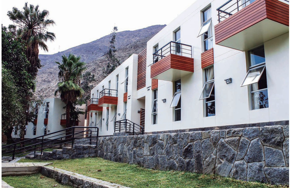
CETEMIN Lima Residencia dormitorios
