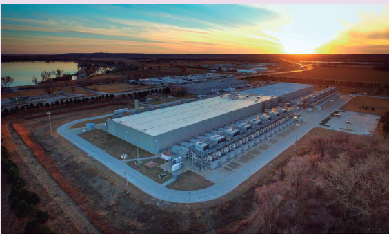
Cada megavatio de capacidad instalada de un centro de datos de IA requiere entre 20 y 50 toneladas de cobre. (Foto: Creative Commons Attribution 2.0 Generic)
