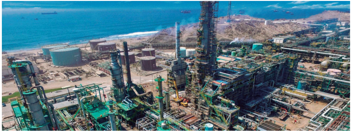
Refinería de Petroperú que no ha alcanzado las metas para las que fue construida
