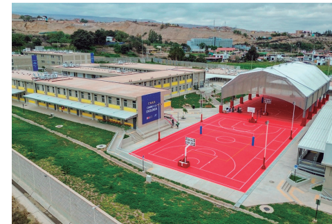
Edificio del COAR Ancash
