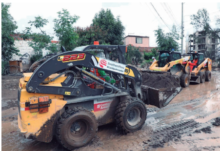
Southern apoyó con maquinaria en la limpieza de la ciudad de Arequipa
