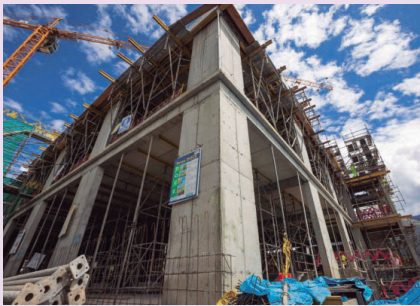
Centro de Salud de Chiquián: avance de obra al 17%
