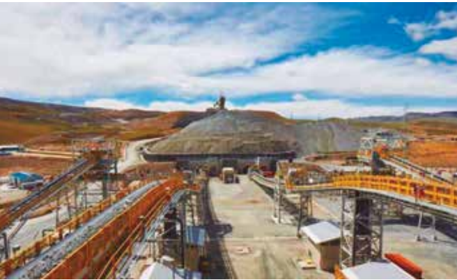
Instalaciones de Constancia que tuvieron que ser paralizadas
