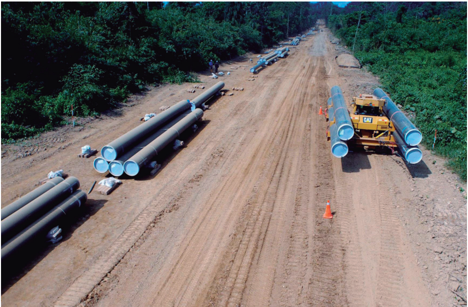
Tuberías que deberían haber sido utilizadas en la construcción del Gasoducto del Sur
