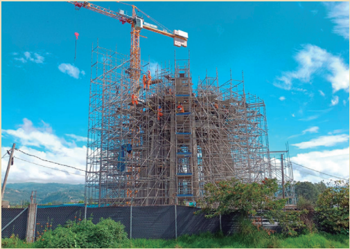
La construcción del reservorio cuenta con un avance del 54%
