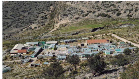
Anexo de Arondaya cuya electrificación será financiada con aportes de Southern Peru
