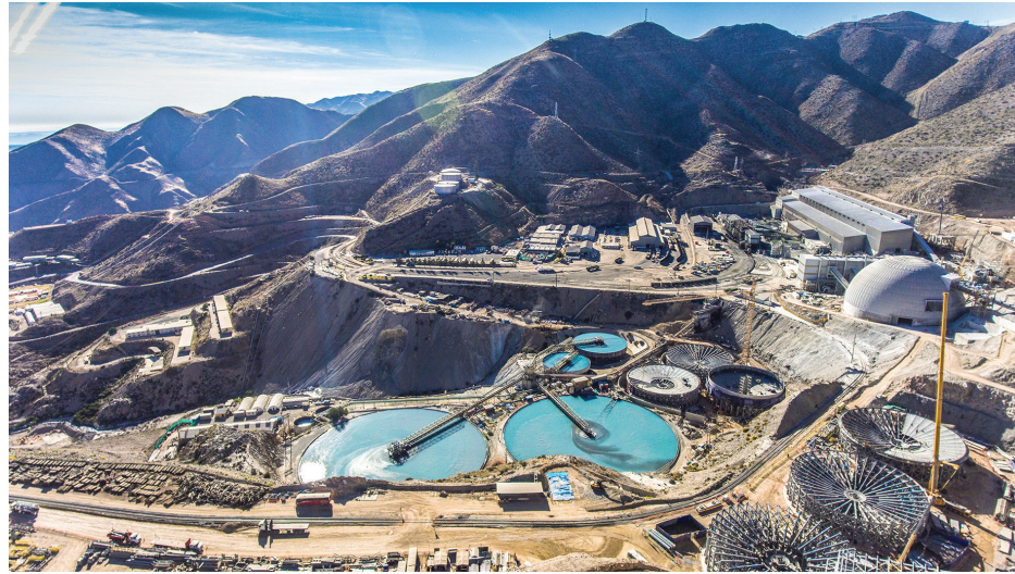
Ampliación de la capacidad de concentración en Toquepala, que incrementará la producción de cobre en el 2018
