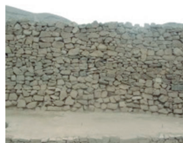
Paredes empedradas, colocadas con precisión, evidencian el manejo de una técnica de ingeniería sorprendente
