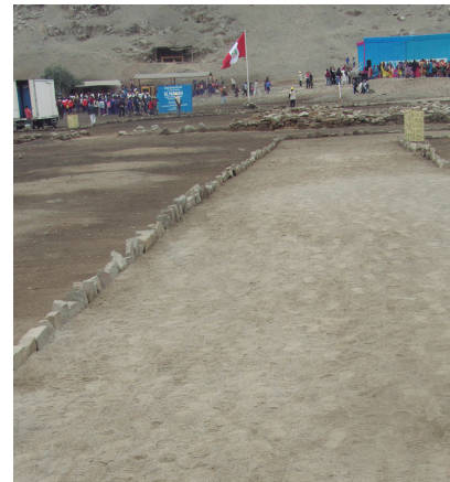
Vista de la pista recién construida
