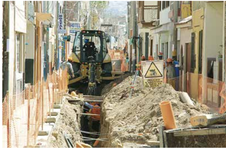
En las obras de saneamiento de Moquegua ya se avanzó 52.3 Km en las redes de agua potable. Falta menos del 10%
